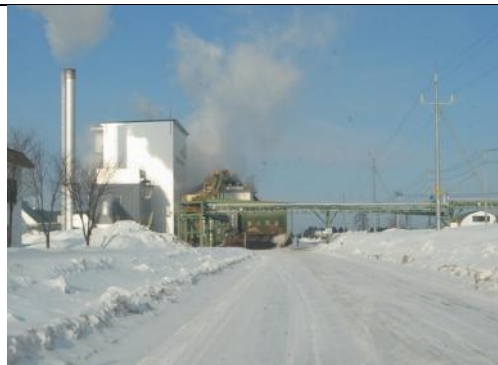
木質バイオマス発電施設
