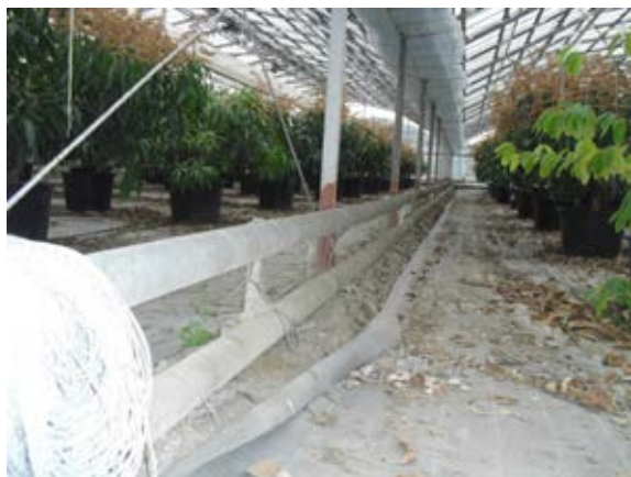
(左) 施設内の温水配管、(右) 施設外の蒸気配管
