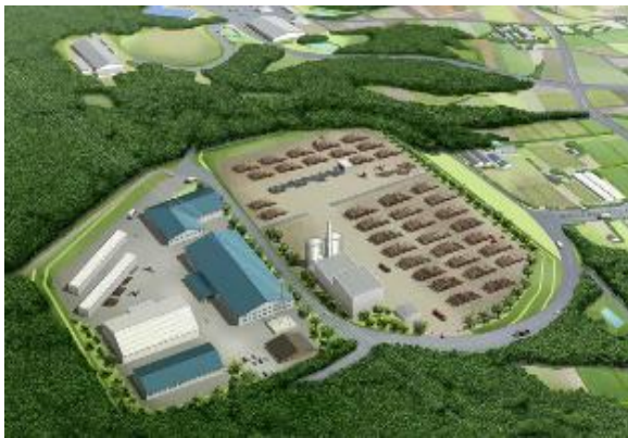
木材加工・木質バイオマス発電施設建設地
